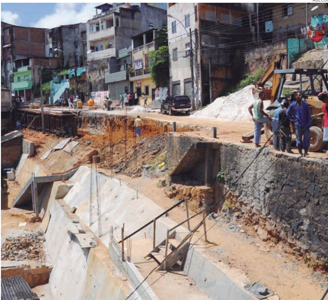
Na Ladeira do Cacau estão sendo realizadas intervenções na drenagem, passeios e melhorias habitacionais
