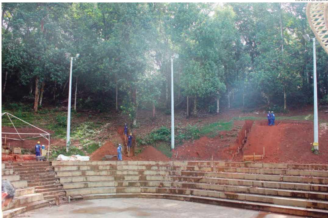
A ampliação do Anfiteatro Dorival Caymmi figura entre as benfeitorias que estão sendo realizadas
