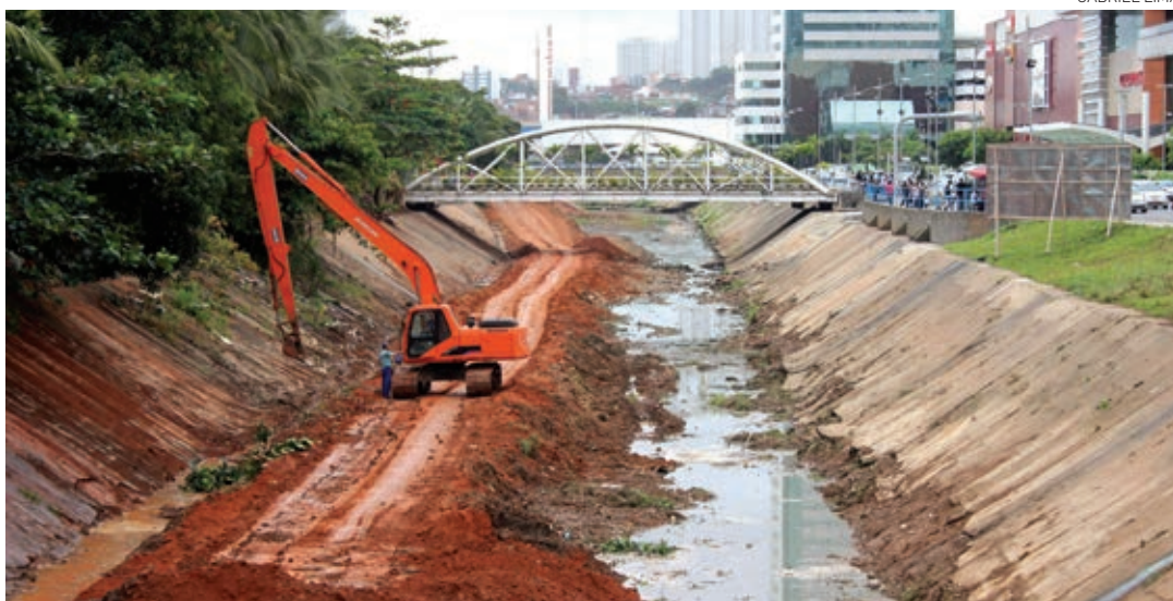
Para reduzir o número de alagamentos, continuam os serviços de micro e macrodrenagem nos córregos, rios e canais
