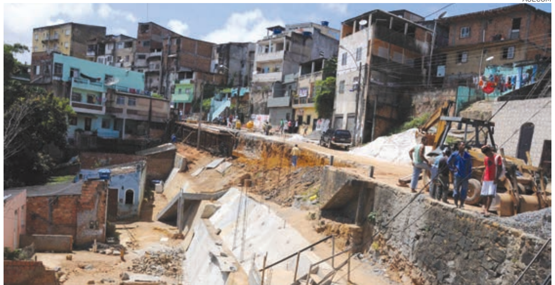
A Ladeira do Cacau passa por recuperação do sistema de drenagem, pavimentação e contenção da encosta
