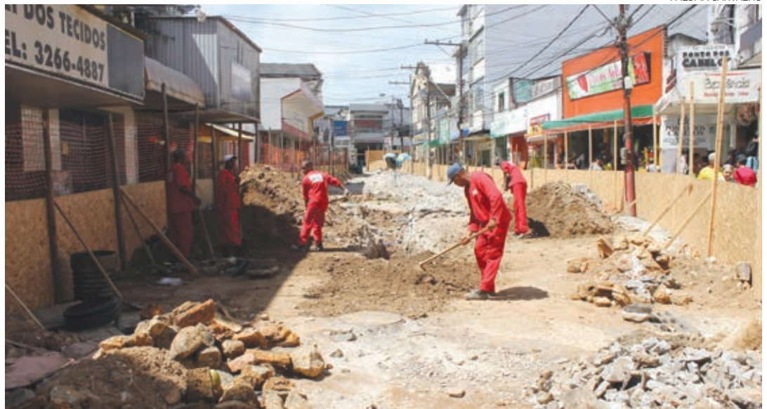
As obras envolvem drenagem, calçamento, implantação de piso intertravado, piso tátil e nova iluminação
