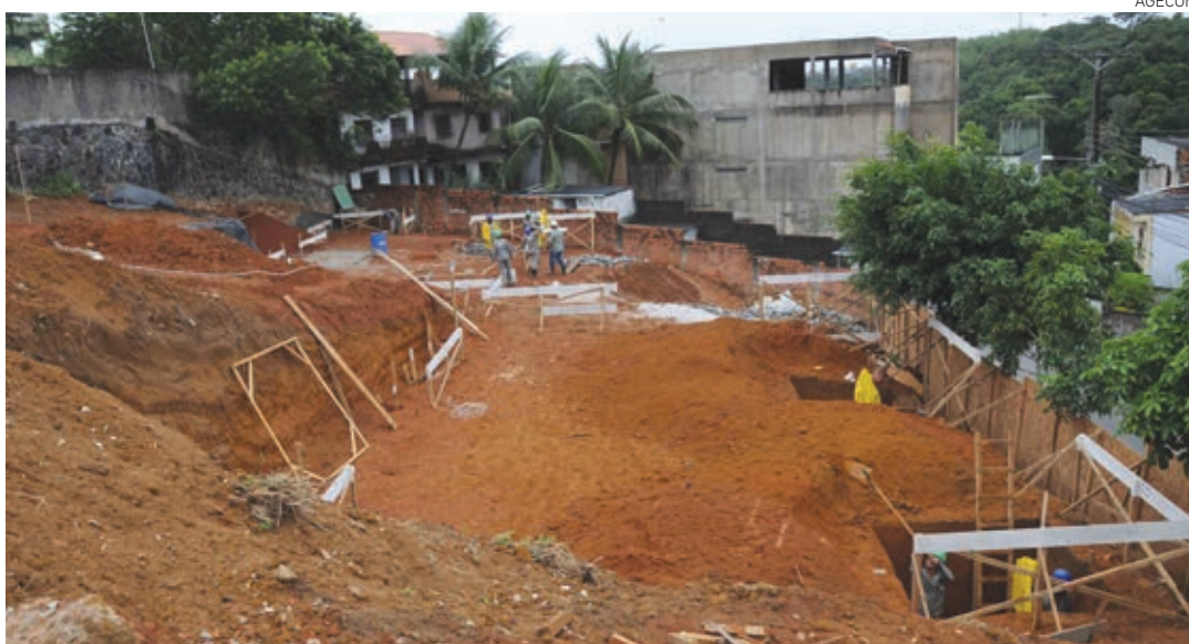
O terreno de 1960 m 2 , no Alto da Cachoeirinha, no Cabula VI, abrigará a unidade escolar, que terá três pavimentos
