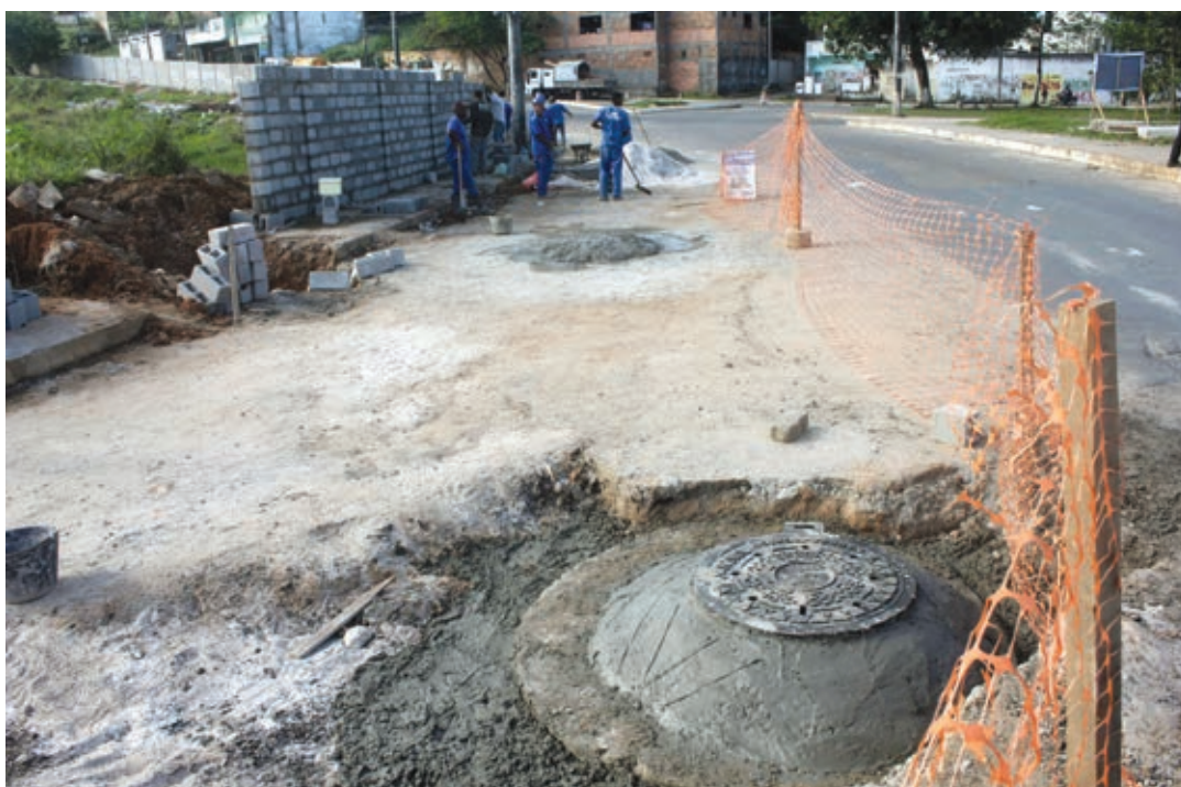
Está em fase de construção uma rede de drenagem mais eficiente e com maior capacidade de vazão da água
