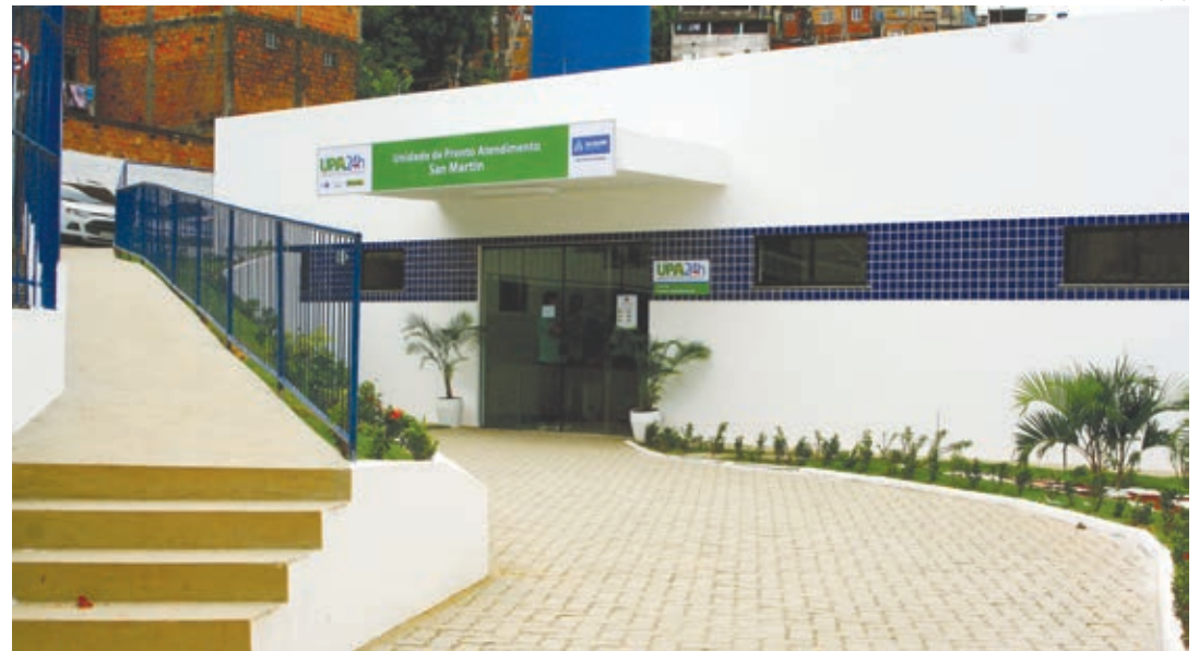
O posto, com 24 leitos, tem 1.500 m 2 de área construída e capacidade para atender até 550 pacientes por dia
