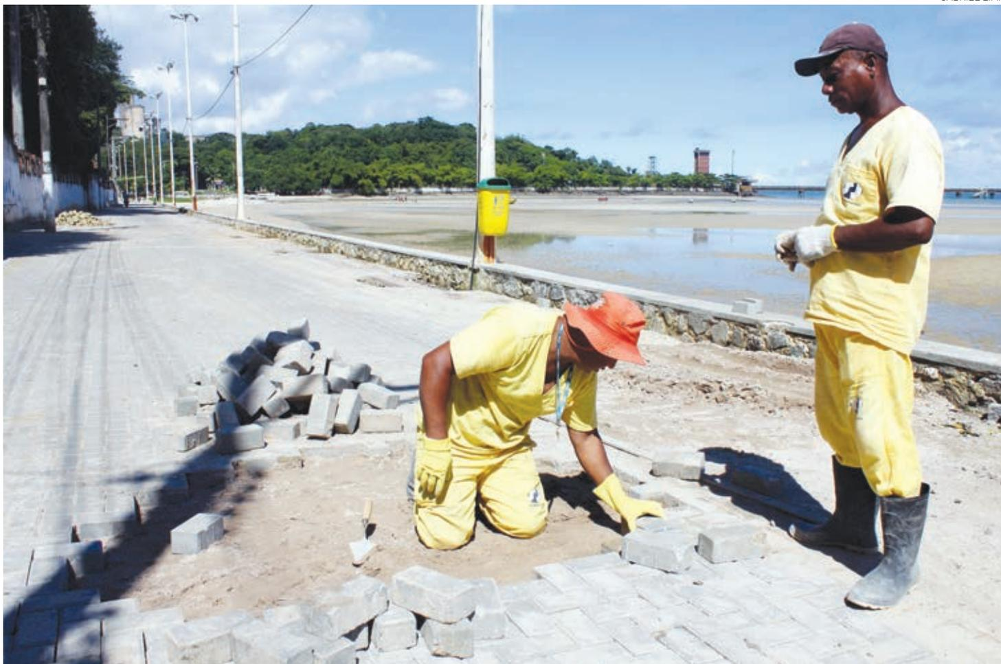
*Os projetos prevêem a substituição da antiga pavimentação e incluem trechos de piso intertravado em pistas compartilhadas por veículos, ciclistas e pedestres*
