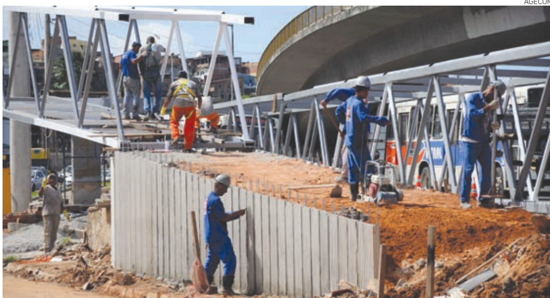
Mesmo liberada para travessia, os trabalhos vão continuar na cobertura, para garantir mais conforto aos pedestres
