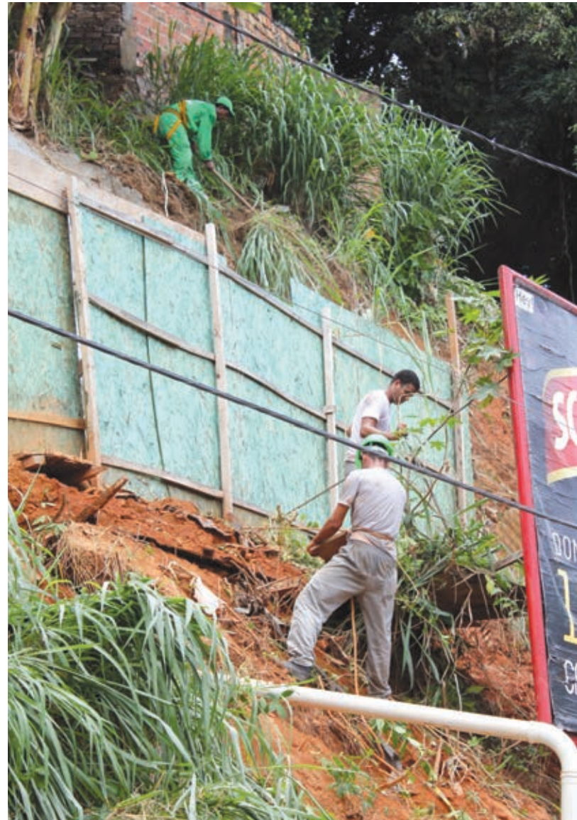
Na Rua Cova da Onça, próxima ao estádio, foi feita a limpeza da encosta
