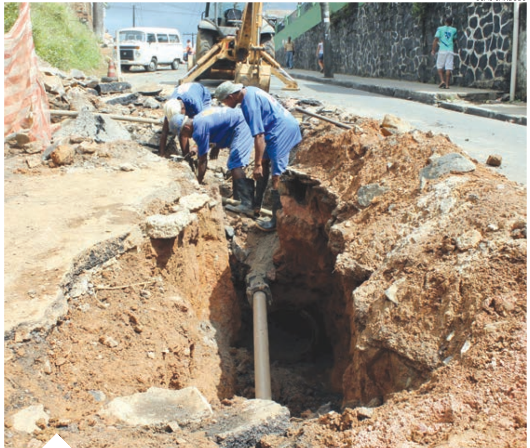
Está sendo feita a manutenção da rede de drenagem, comprometida em razão de um rompimento na rede de esgoto da Embasa
