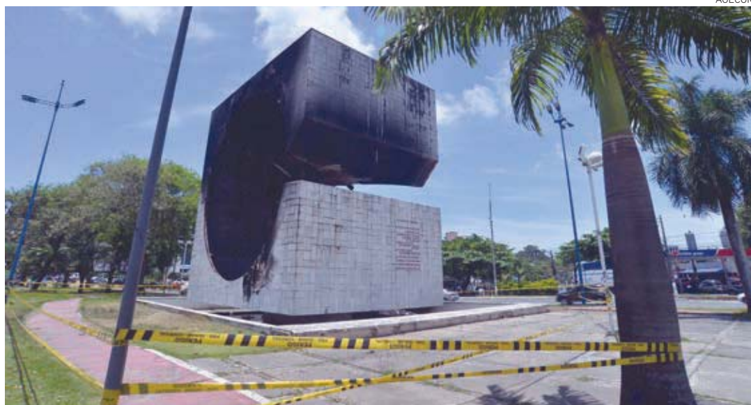
A obra do artista Mário Cravo, inaugurada em 1983, na Garibaldi, foi atingida por um incêndio em outubro do ano passado
