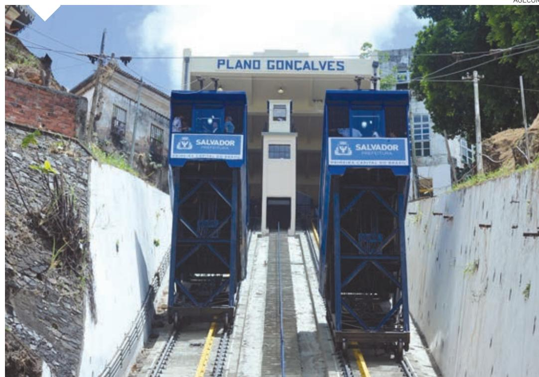
Os serviços incluíram o remodelamento de peças como motores, caixas de comando e recuperação total dos dois bondes
