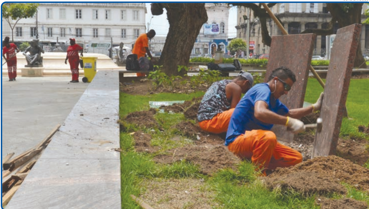
Substituição do granito danificado, recuperação da fonte e do sistema de irrigação, pintura do gradil e bancos estão entre os serviços na Piedade
