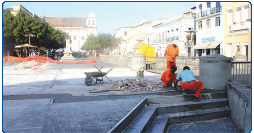
A Praça da Sé passou por limpeza geral do piso com aplicação de resina para proteção e impermeabilização
