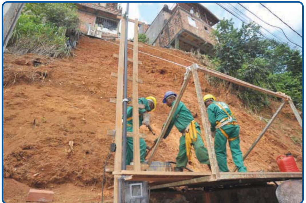
A Prefeitura está investindo R$ 400 mil nas obras de contenção da encosta da Rua Nova do Bariri
