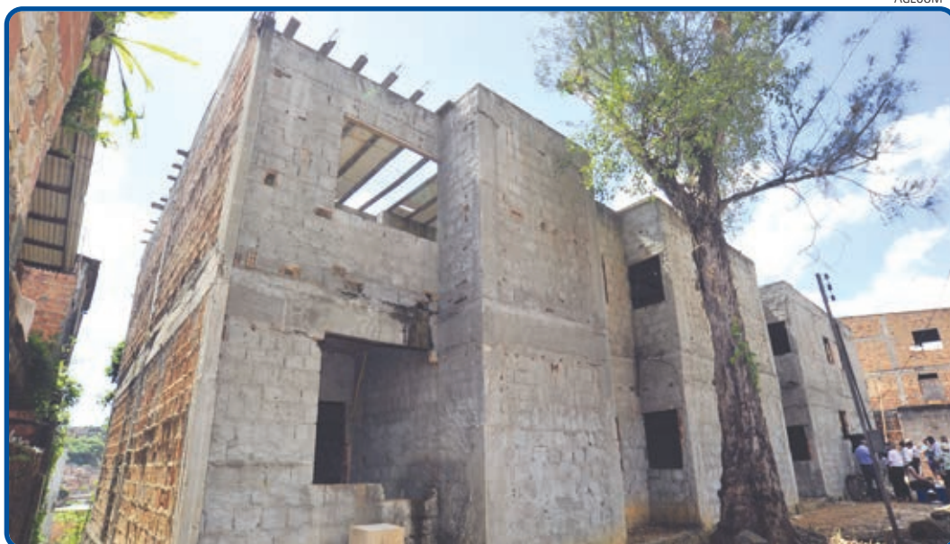
A USF Boa Vista de São Caetano, que em 2011 teve as obras paralisadas, será devolvida à comunidade reformada
