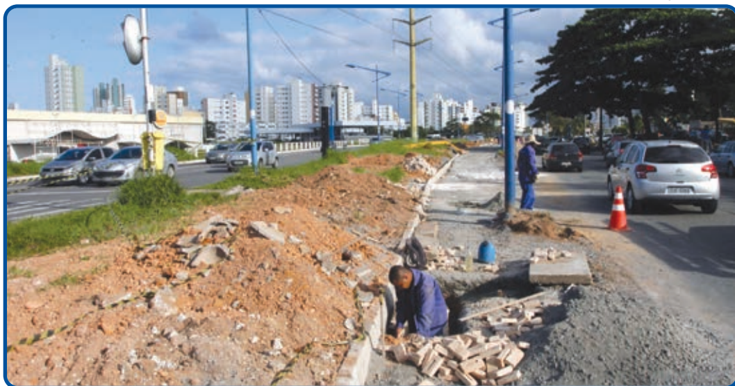
A obra, que vai melhorar o tráfego na Avenida Paulo VI, exigiu o remanejamento de postes de iluminação
