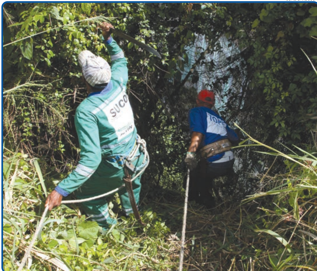
As árvores tiveram que ser erradicadas porque, em caso de queda, poderiam derrubar a encosta de onde brotaram
