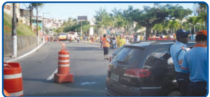
A Transalvador atuou na fiscalização do trânsito e instalação de barreiras
