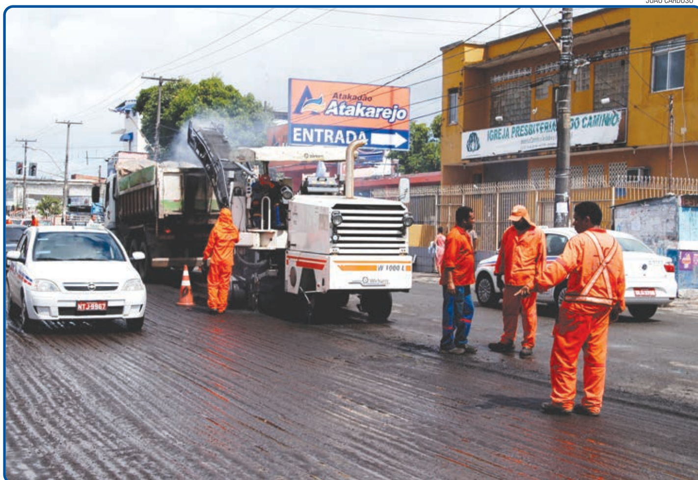
O trabalho envolve a retirada da antiga pavimentação, aplicação de pintura de ligação que serve para fixar o novo piso e colocação da camada de asfalto
