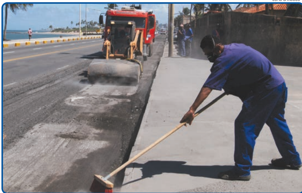
Os serviços estão sendo realizados na Av. Juracy Magalhães e Caminho de Areia e no trecho entre Itapuã e Pituba
