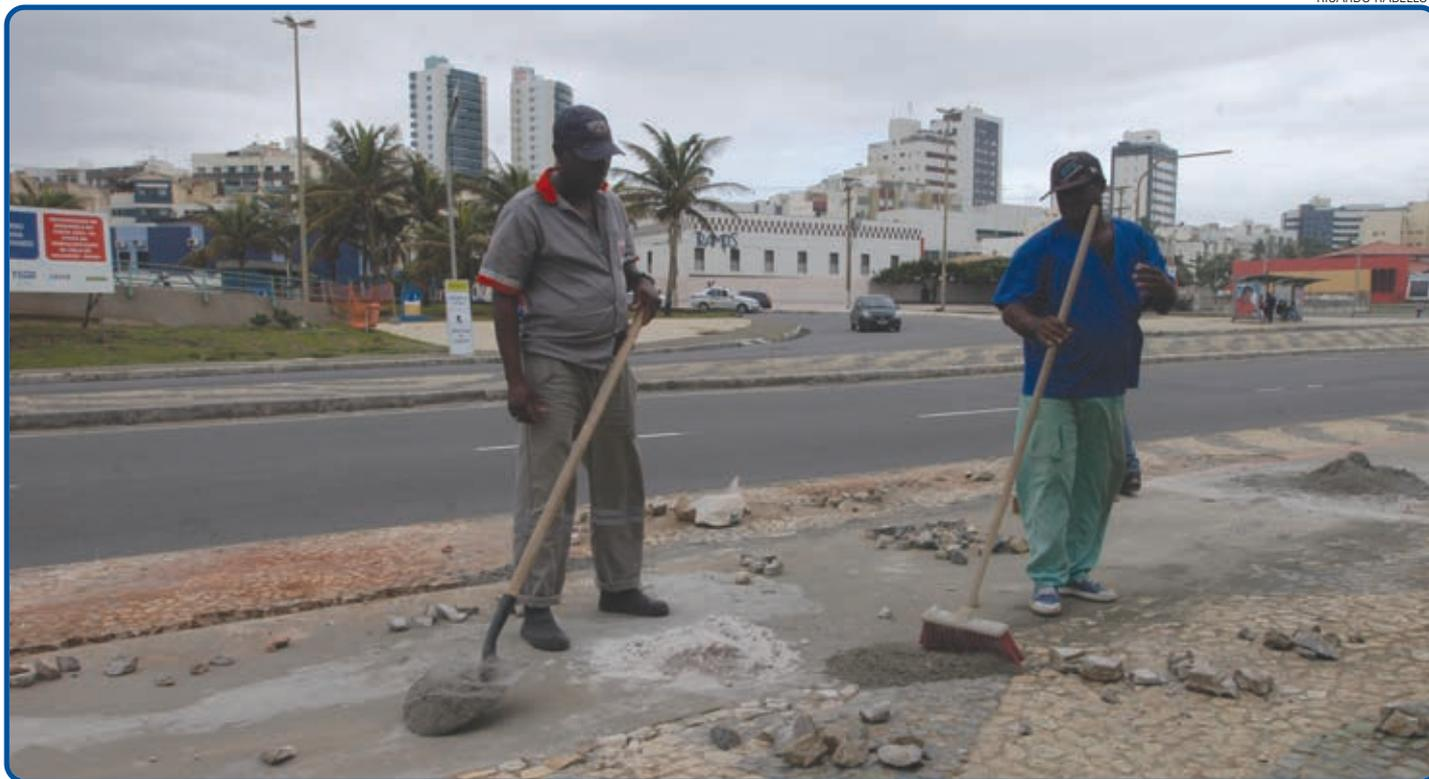
O serviço está sendo realizado no trecho entre o Costa Azul e a Boca do Rio e inclui ainda limpeza das caixas de drenagem e nivelamento das caixas com o piso
