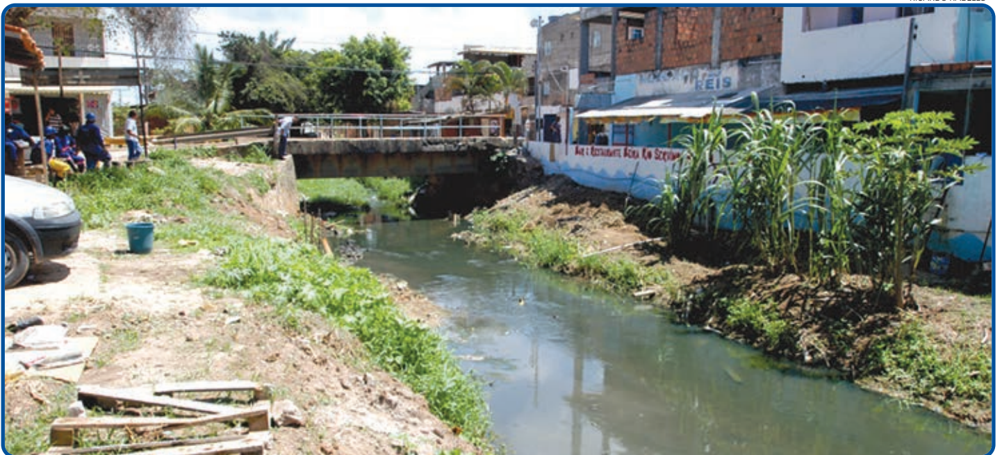
Foram retirados mais de oito mil metros cúbicos de materiais, a exemplo de pneus, que impediam o fluxo do rio e provocavam alagamentos
