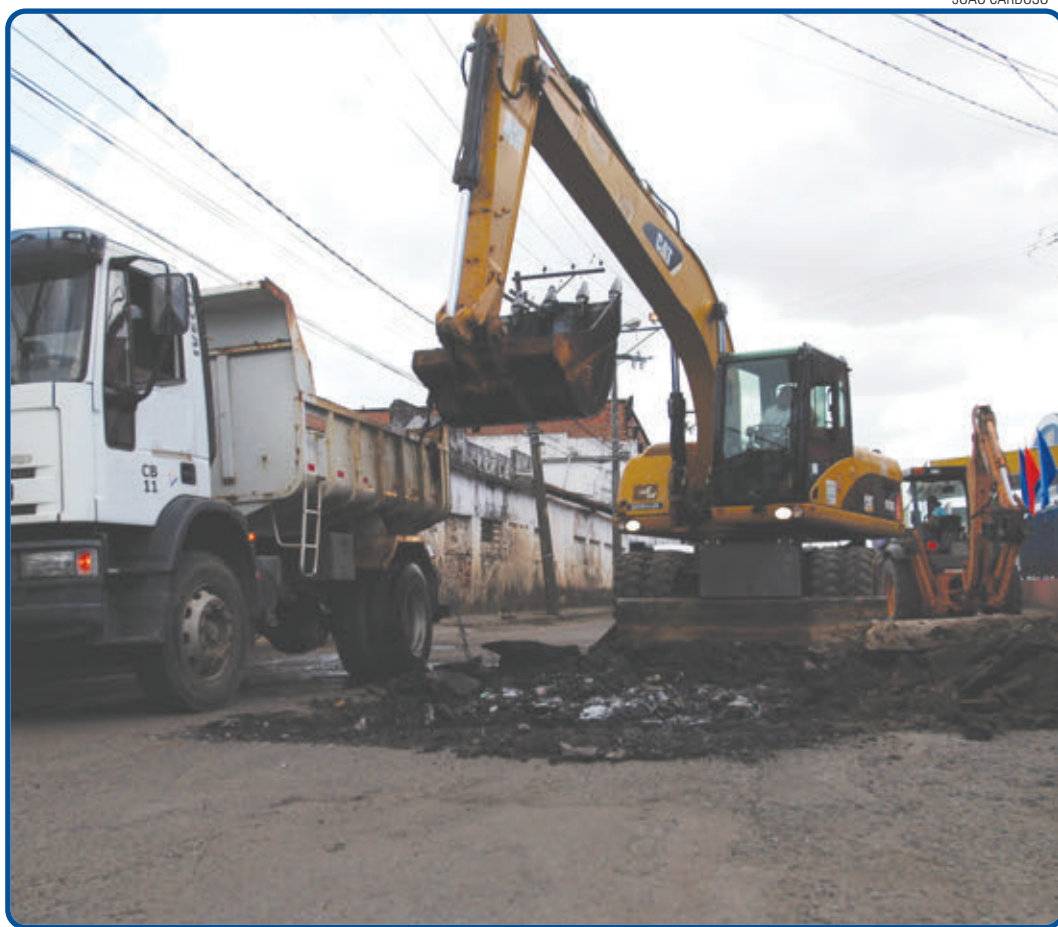
As obras que serão realizadas em três etapas, com duração de oito meses, foram iniciadas no último final de semana
