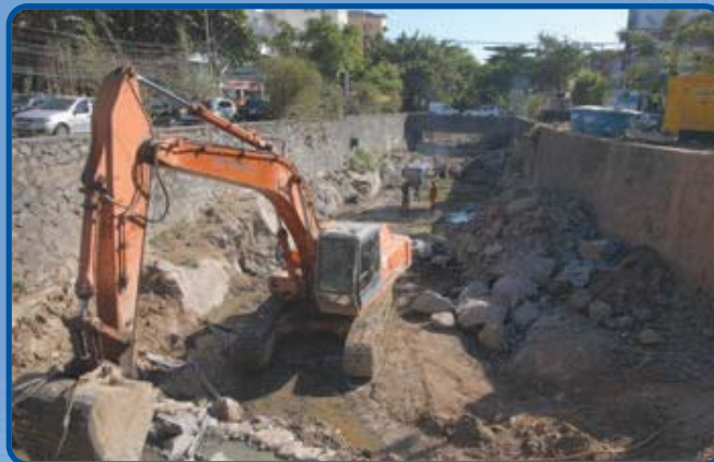
As obras realizadas no fundo das galerias do canal do Lucaia, que integram o conjunto de intervenções na Vasco da Gama, facilitarão o escoamento da água e acabarão com o mau cheiro na região
