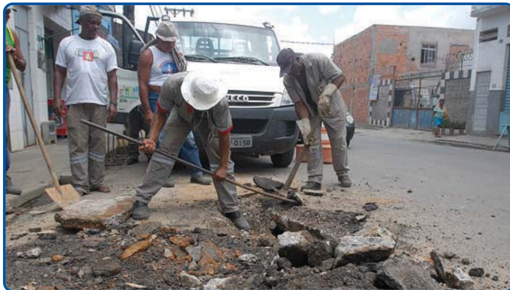
Obra atende reivindicação de comerciantes e moradores do local e envolve cerca de 10 funcionários da Sucop
