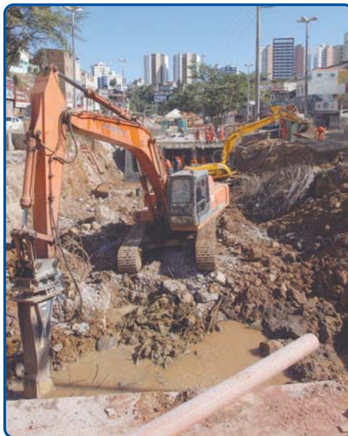
Além de outros benefícios, o término das obras vai marcar o fim dos alagamentos, beneficiando diretamente motoristas e a comunidade local
